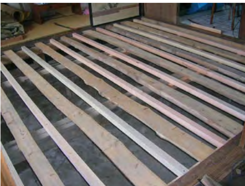
1階の床組改修を実施中
