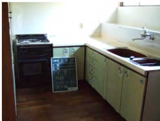
台所の流し台や給湯設備の交換、内装の改修等を実施 地域住宅交付金を利用し、約113万円の補助を実施済
