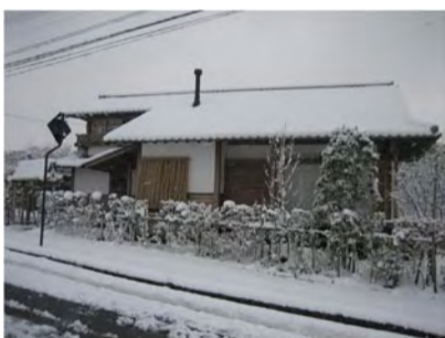
② 冬のエコハウス 南外観 この地域では非常に珍しい大雪が降る。こんな日でも薪ストーブで家のなかは快適。
