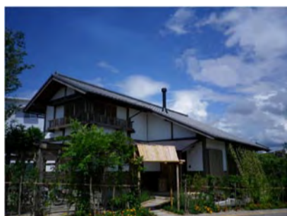
① 夏のエコハウス 西外観 南側へ深く出た庇とグリーンカーテンで真夏の強い日差しも遮蔽。不快な梅雨時期でも窓を開けられる。
